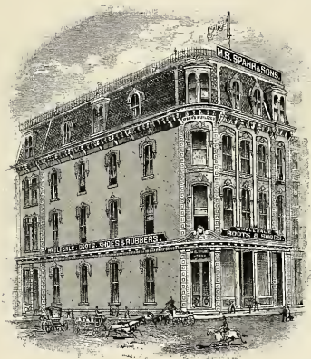
M. B. SPAHR BUILDING, YORK, PA.
